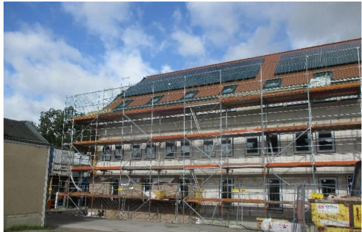
Baumaßnahme Rathaus Stadt Pattensen
