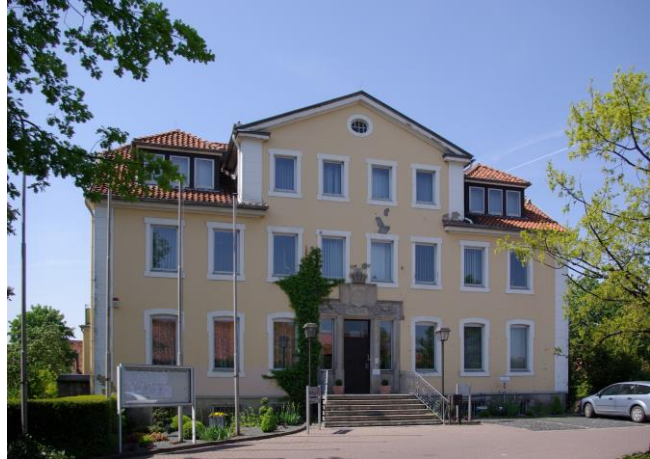
Altes Rathaus Stadt Pattensen (Bestandsgebäude)
