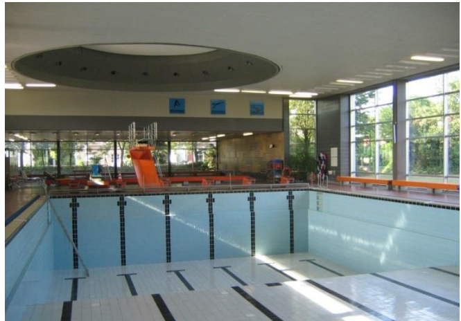
Schwimmbad Stadt Achim (Bestandsgebäude)
