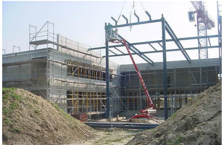
Rohbau Gymnasium Stadt Twistringen
