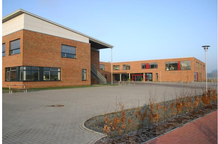
Gymnasium Twistringen (2. Bauabschnitt)
