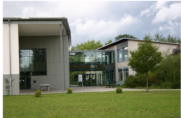
Erweiterung Hauptschule Gemeinde Isernhagen
