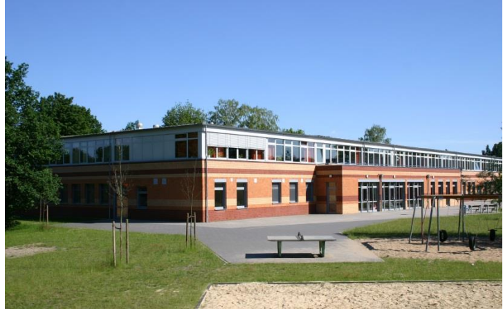
Hauptschule Stadt Achim
