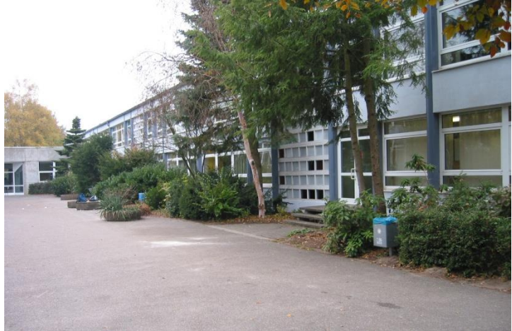
Realschule Stadt Achim (Bestandsgebäude)
